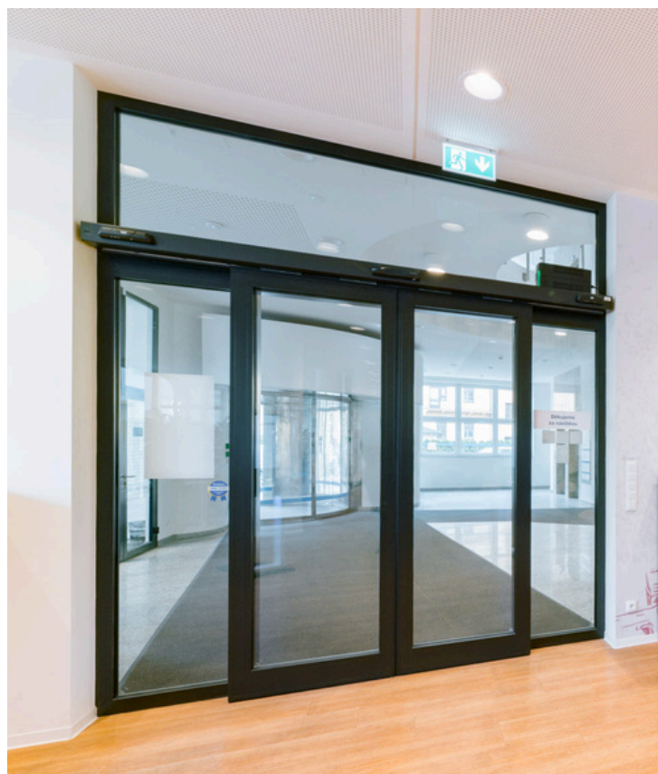
Pohled z vnitřní strany
